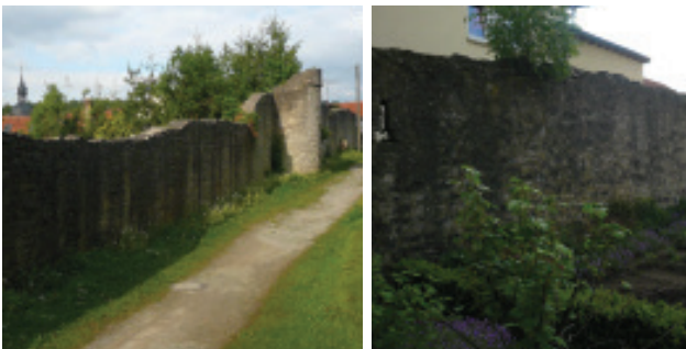
Ortsmauer mit angrenzenden Freiflächen
