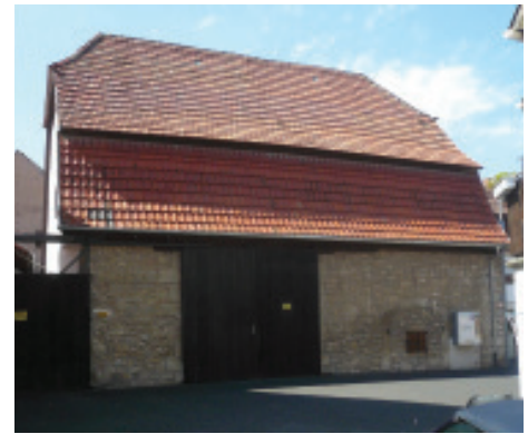
Scheune im Domherrnviertel Muschelkalkfassade Mansarddach und giebelseitiger Schopfwalm
