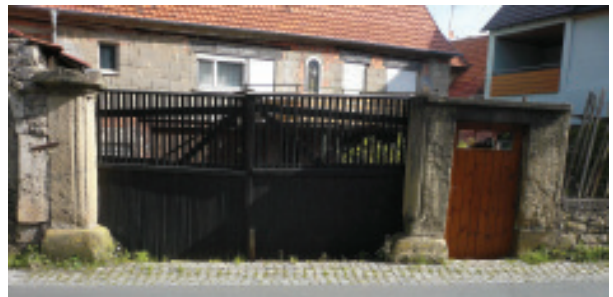
Hoftoranlage mit Sandsteinpfeilern
