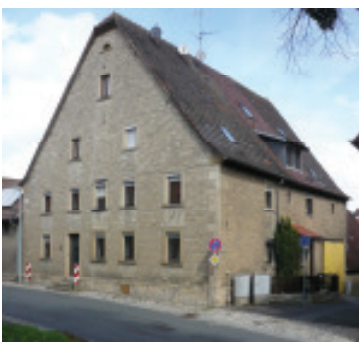
Natursteinmauerwerk – Muschelkalk
