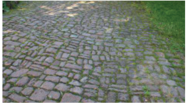
Mit Muschelkalk gepflasterte Hoffläche
