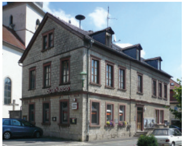
Ehemaliges Rathaus und Schule, erbaut 1892, zweigeschossiges Muschelkalkgebäude mit roten Sandsteingewänden und Gurtge- simsen, Linke Bachgasse 12
