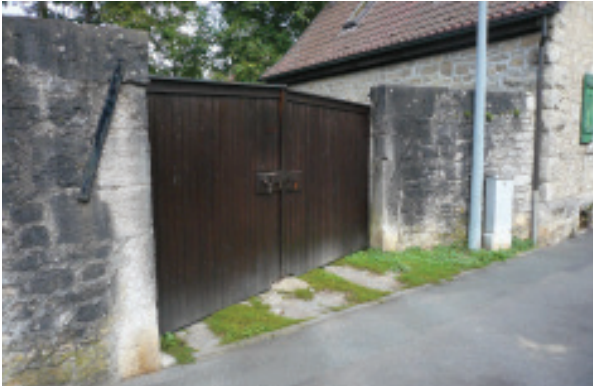
Muschelkalkmauer mit Hoftor aus Holz
