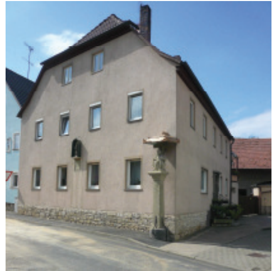
Linke Bachgasse 8 (Denkmal)
