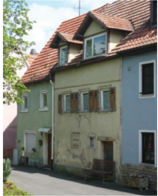
Rechte Bachgasse 19 (Baudenkmal, 18 (Baudenkmal) und 17
