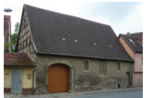
Scheune in der Zehnthofstraße Muschelkalkfassade mit Fachwerkgiebel
